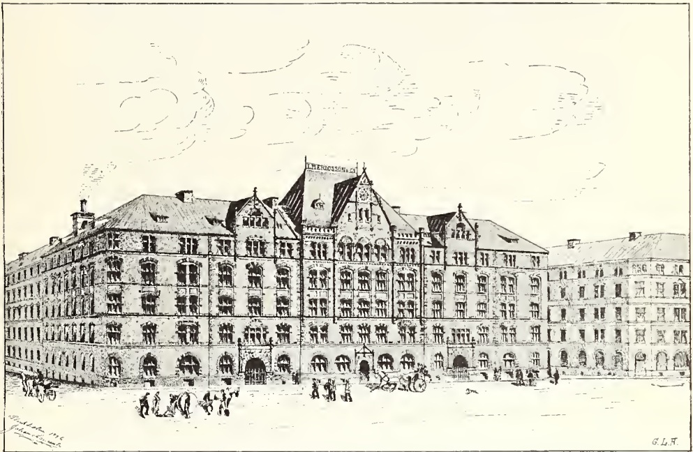
101. L. M. Ericsson & kais fabriksbyggnad, Tulegatan nr 15, 17 och 19.
